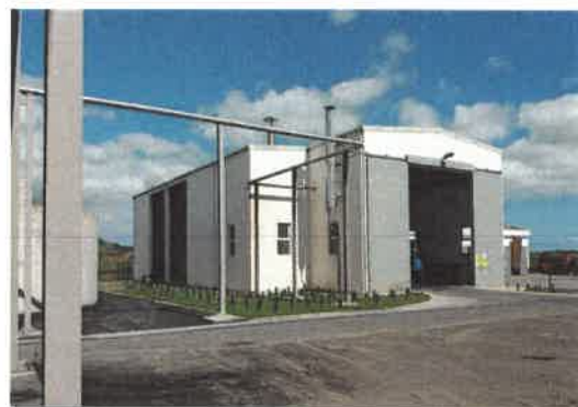
FIGURA 4: CENTRO DE PROCESSAMENTO DE SUBPRODUTOS DE ORIGEM ANIMAL
