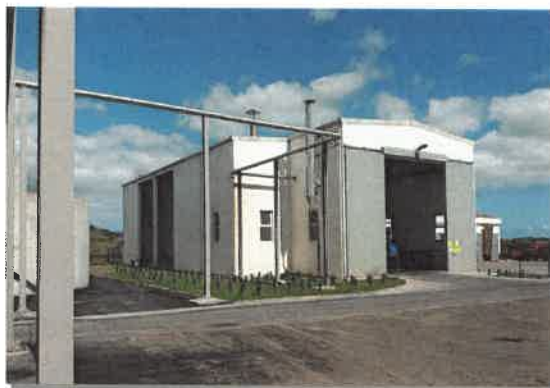
FIGURA 5: CENTRO DE PROCESSAMENTO DE SUBPRODUTOS DE ORIGEM ANIMAL
