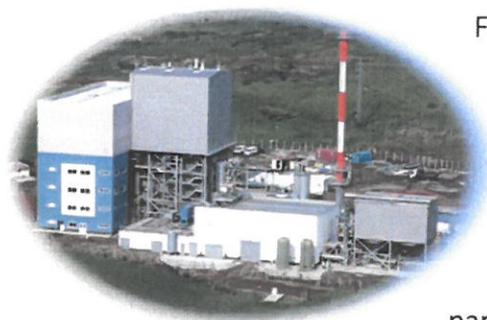
Foram realizadas duas paragens programadas, que corresponderam a 41 dias de manutenção programada. A segunda paragem em outubro foi de 21 de dias, necessária para uma grande intervenção no gerador do turbogruppo, no âmbito da garantia contratual (substituição do rotor) e ainda para demolição e reposição de parte do refratário da fornalha com reposição de ancoragens que obrigou a um arranque prolongado para cura do material aplicado.
